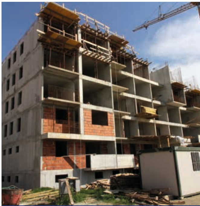
Radovi na izgradnji zgrade u Prijedoru, maj 2017.
